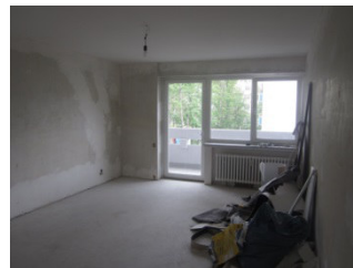
Innenansicht - leerstehende Wohnungen (Ist-Zustand)
